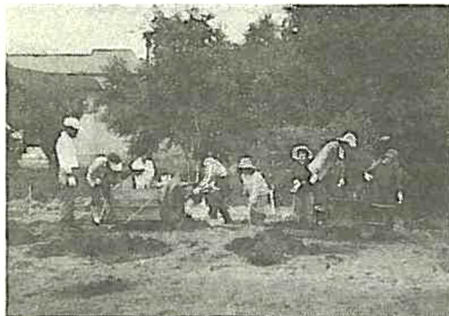
写真1 コートの土運搬
