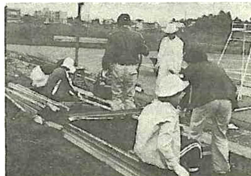
写真2 フェンスの作成
